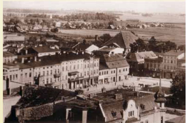
Widok na Kamsiadkę z Rynku, początek lat 90.
