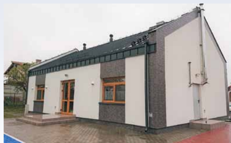
Dzięki wsparciu z PROW 2014-2020 w ramach inicjatywy LEADER Gmina Bralin zrealizowała inwestycję polegającą na budowie Domu Ludowego w Nosalach. Źródło: UG Bralin
