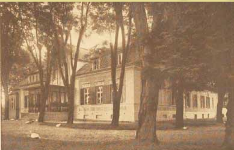
Prewentorium. — Ustronie. — Budynek zakładowy.
